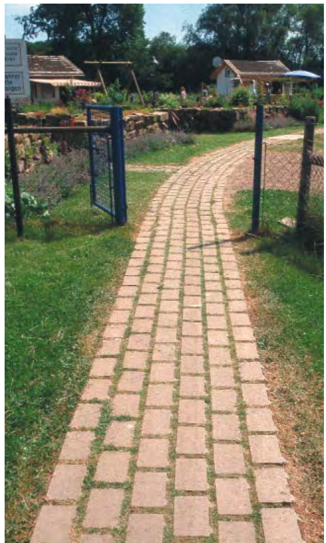
Fußweg in Rasenfugenpflaster
