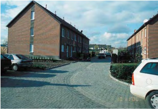
Mittelrinne aus Betonpflaster in Mischverkehrsfläche
