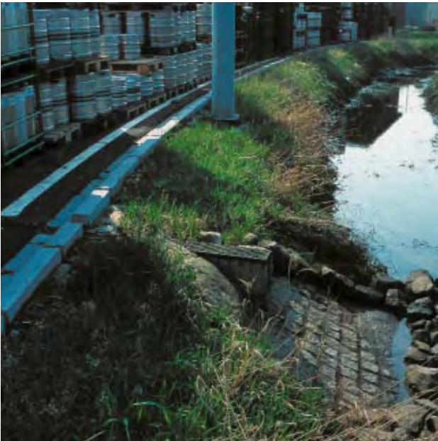
Zustand direkt nach Fertigstellung
