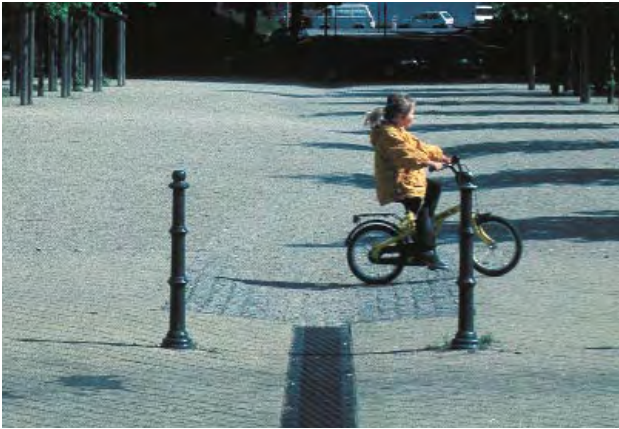
Mittelrinne aus Natursteinpflaster in wassergebundener Decke
