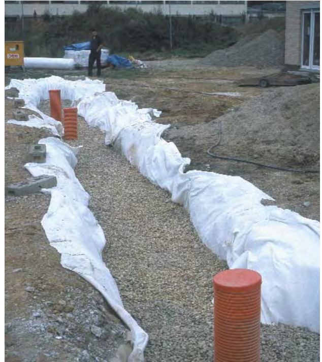
Rigole mit Kies aufgefüllt
