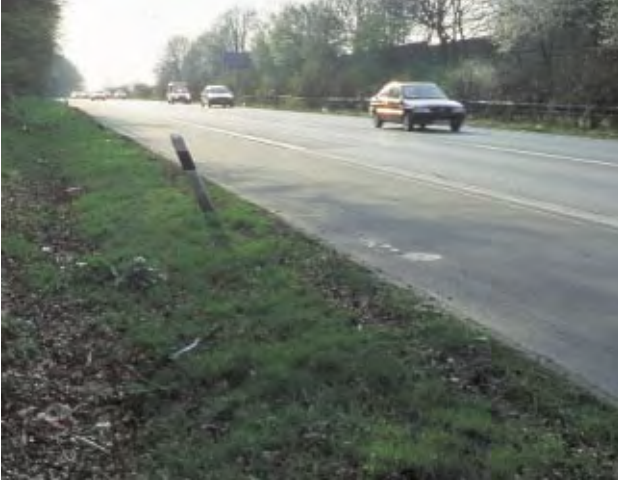
Laubablagerungen straßenbegleitende Mulde
