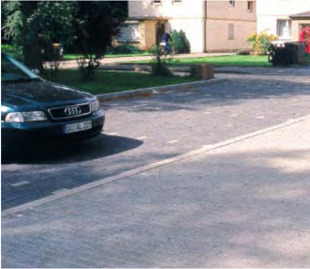
Stellplatzanlage mit porösem Betonpflaster
