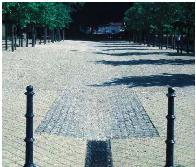
Zuordnung wassergebundene Decke – erhöhter Sedimenteintrag
