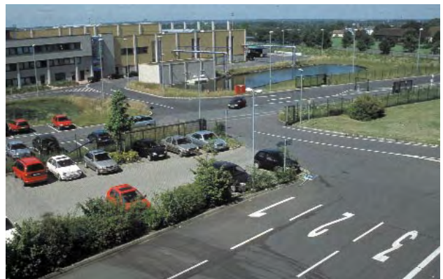
Regenwassergespeister Löschwasserteich mit umlaufender Versickerungszone
