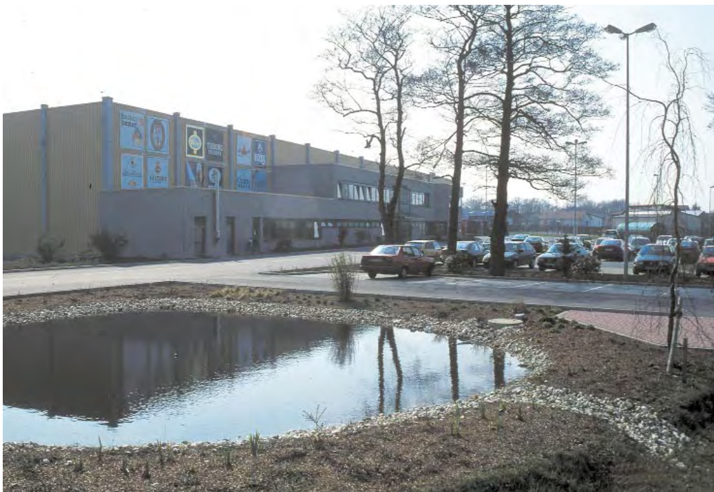
Teich mit Überlauf in Versickerungsmulde - Gewerbebetrieb
