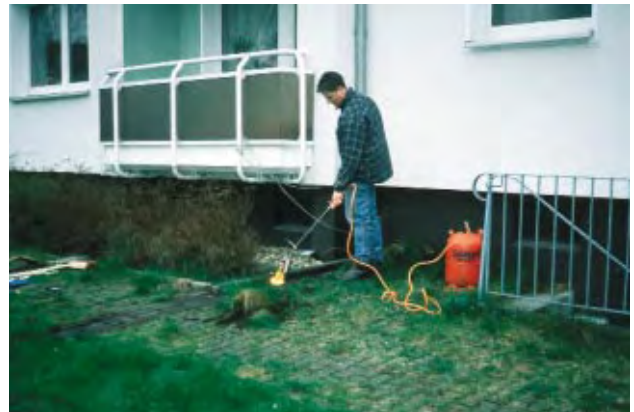
Abflammen des Pflanzenaufwuchs in den Fugen
