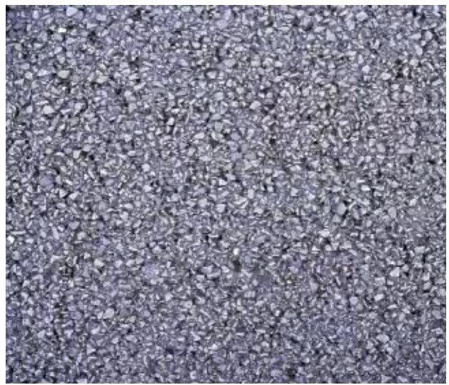
Dränasphalt gereinigt - hohe Versickerungsleistung
