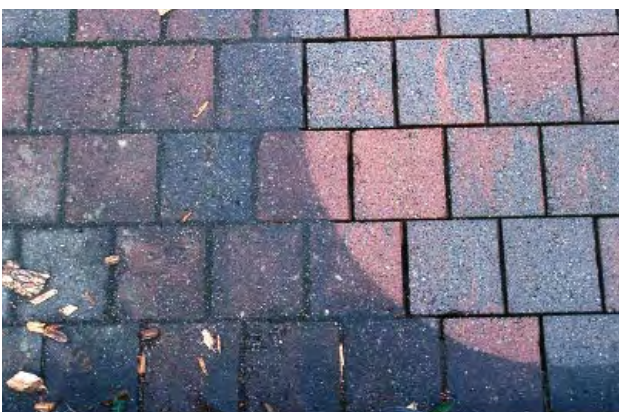
Verschmutztes / gereinigtes Sickerfugenpflaster
