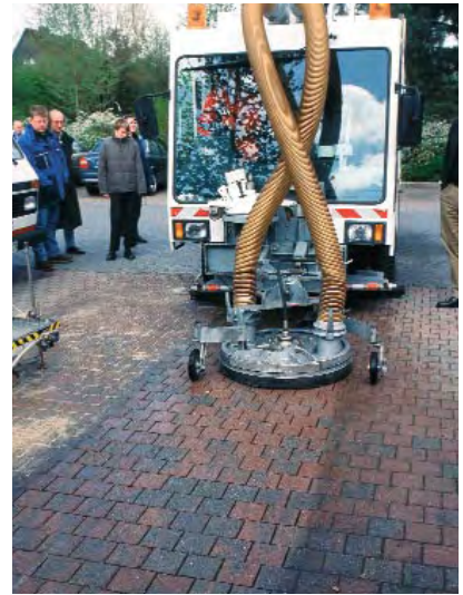
Reinigung mit Hochdruck-Absauggerät (Saug-Spül-Verfahren)
