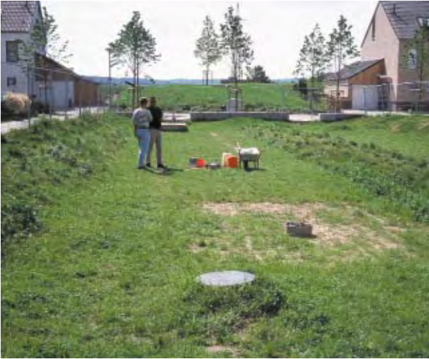
Funktionsüberprüfung schadhafter Versickerungsmulde
