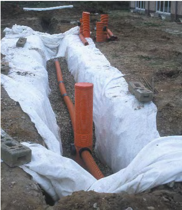
Dränrohre, Kontrollschächte und Geotextil
