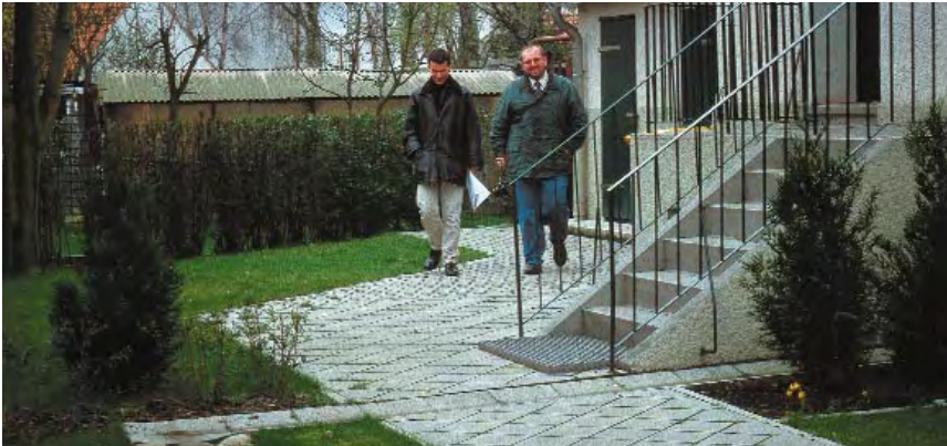
Offene Rinne aus Betonfertigteilelementen
