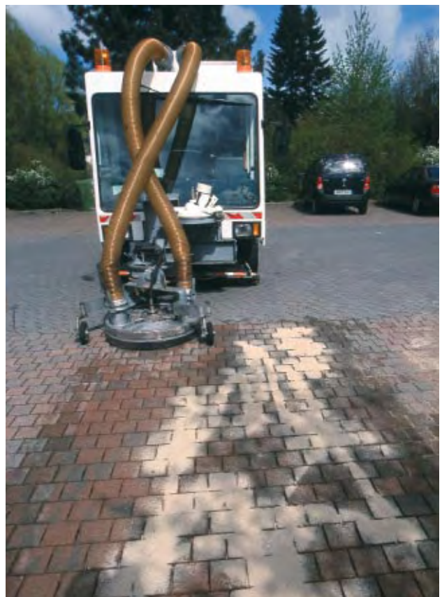
Neuverfugen gereinigten Sickerfugenpflasters
