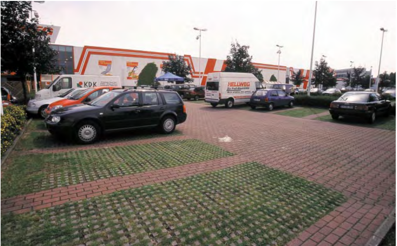
Rosengitterstein auf Stellplatzflächen eines Baumarktes
