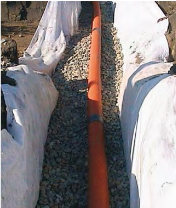
Dränrohr in linienförmiger Mulden-Rigole
