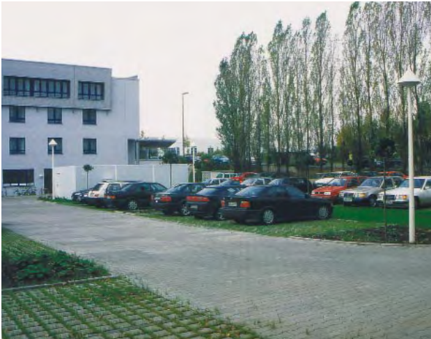
Stellplatzanlage – Stellflächen in Rasenfugenpflaster
