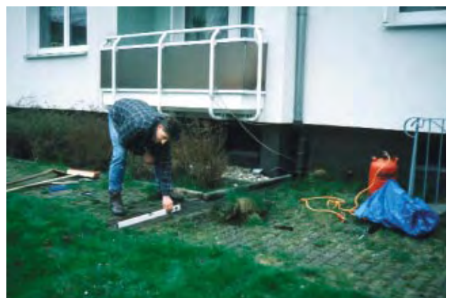
Kontrolle des Längsgefälles
