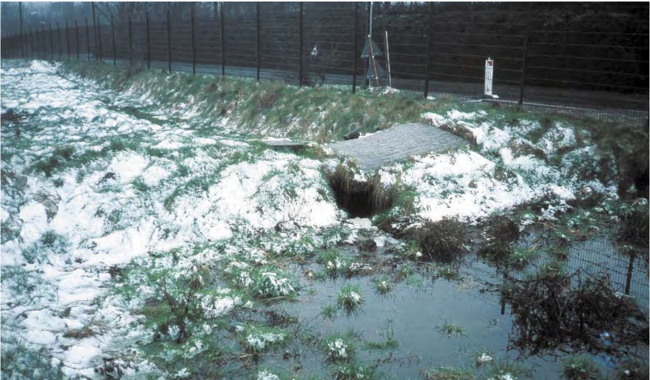
Unterspülter und absackter Notüberlauf
