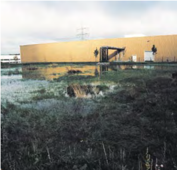
Rohrbrücken zur offenen Ableitung des Niederschlagswassers (Freispiegelleitung)
