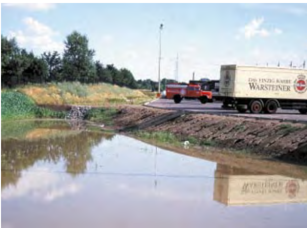
Wiederhergestellte Versickerungsanlagen nach erforderlichem Bodenaustausch
