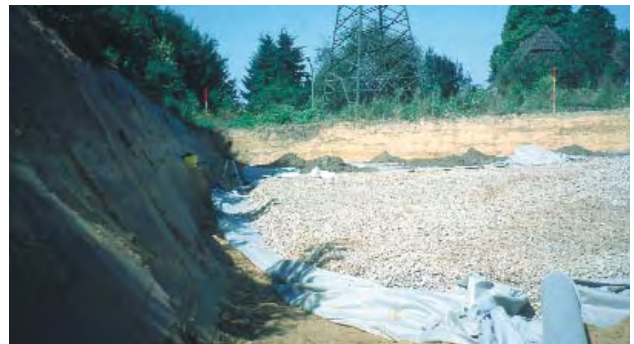
Großflächige Mulden-Rigole im Bau
