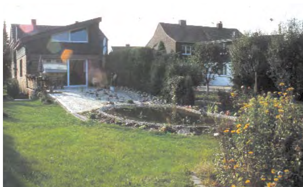
Teich mit Überlauf in Versickerungsmulde – Einfamilienhaus
