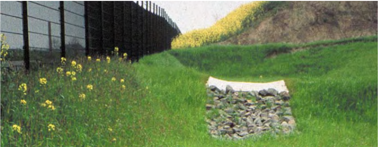
Überlauf einer Mulden-Rigolen-Kaskade
