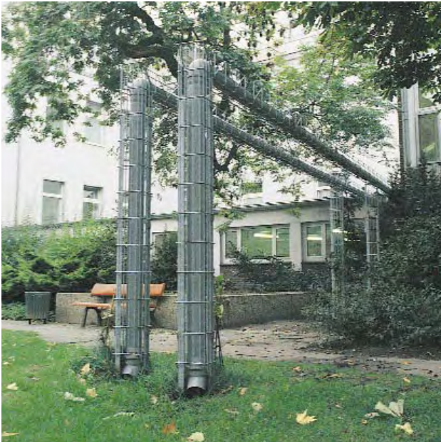
Rohrbrücke bei einem Krankenhaus
