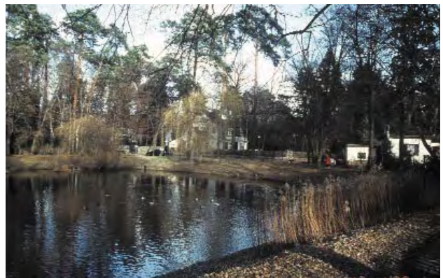
Versickerungsbecken mit Dauerstauzone seit 80 Jahren erfolgreich in Betrieb (Berlin-Frohnau)
