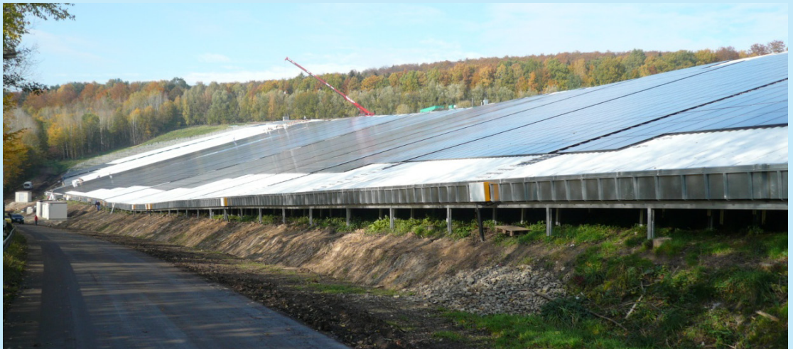
Abb. 12 Photovoltaikanlage bei der Endmontage der Module Deponie Dörentrup (Kreis Lippe)
