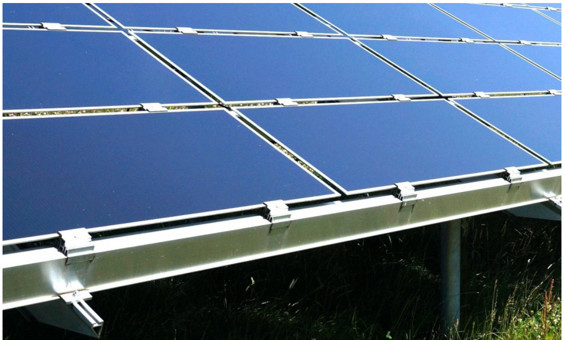
Abb. 3 Solarmodule auf einem Modulträger. Die Lücken zwischen den Modulen ermöglichen das Abtropfen von Niederschlagswasser ohne Erosionsgefahr
