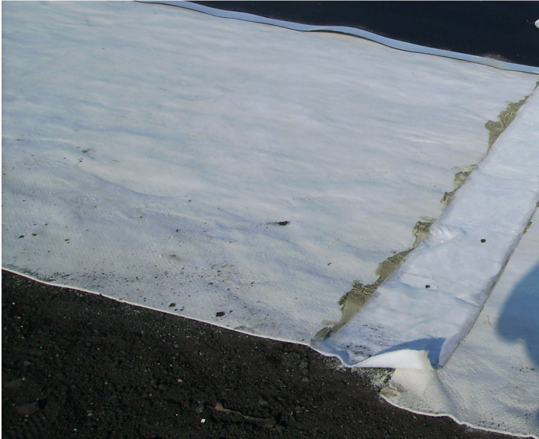
Abbildung 7 geosynthetische Tondichtungsbahn Überlappungszone (Querstoß) mit aufgetragener Bentonitpaste Foto: Naue GmbH & Co. KG
