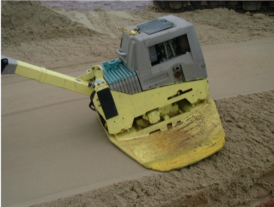
Abbildung 8 Verdichtung einer TRISOPLAST-Dichtungsschicht
