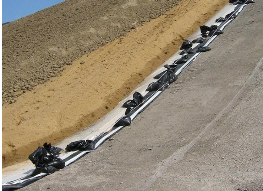
Abbildung 6 Rekultivierungsschicht mit Zoneneinteilung Gestuffer Aufbau der Rekultivierungsschicht auf Geogitter, Dränmatte und Kunststoffdichtungsbahn Foto: HYDR.O. Geologen und Ingenieure
