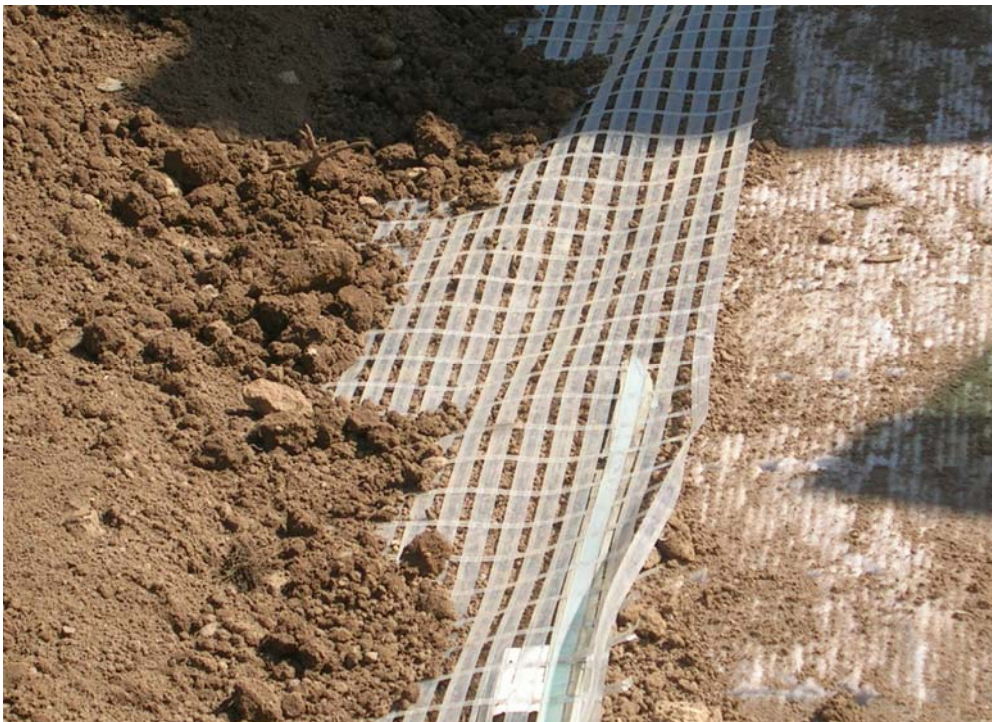
Abbildung 4 gelegtes Geogitter in einer steilen Böschung
