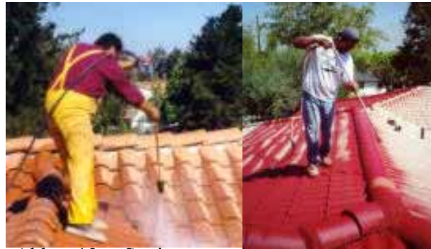
Abb. 12: Sanierung eines Hausdaches (Quelle: American Rooftile coatings, http://www.americanrooftilecoatings.com )
