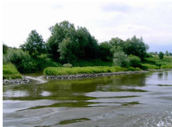
Abb. 68: Der durch die Schifffahrt verursachte Wellenschlag wird durch Seitenleitwerke vom Ufer ferngehalten. Die so geschützten Bereiche sind Aufenthaltsorte für Jungfische. Hier wachsen Makrophyten, und Wirbellose finden besiedelbare Substrate.
