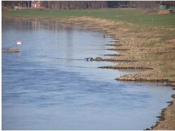
Abb. 69: Durch Bühnen wird der Niedrig- und Mittelwasserstand in der Schifffahrtsrinne reguliert.
