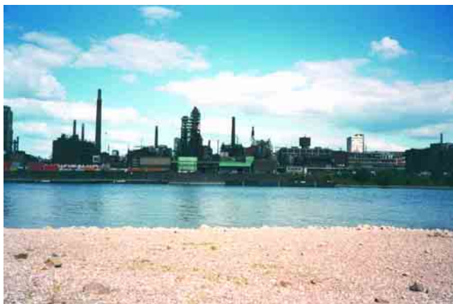
Abb. 29: Verbaute Ufer wie hier bei Leverkusen unterbinden eine Lateralerosion des Stromes vollständig.
