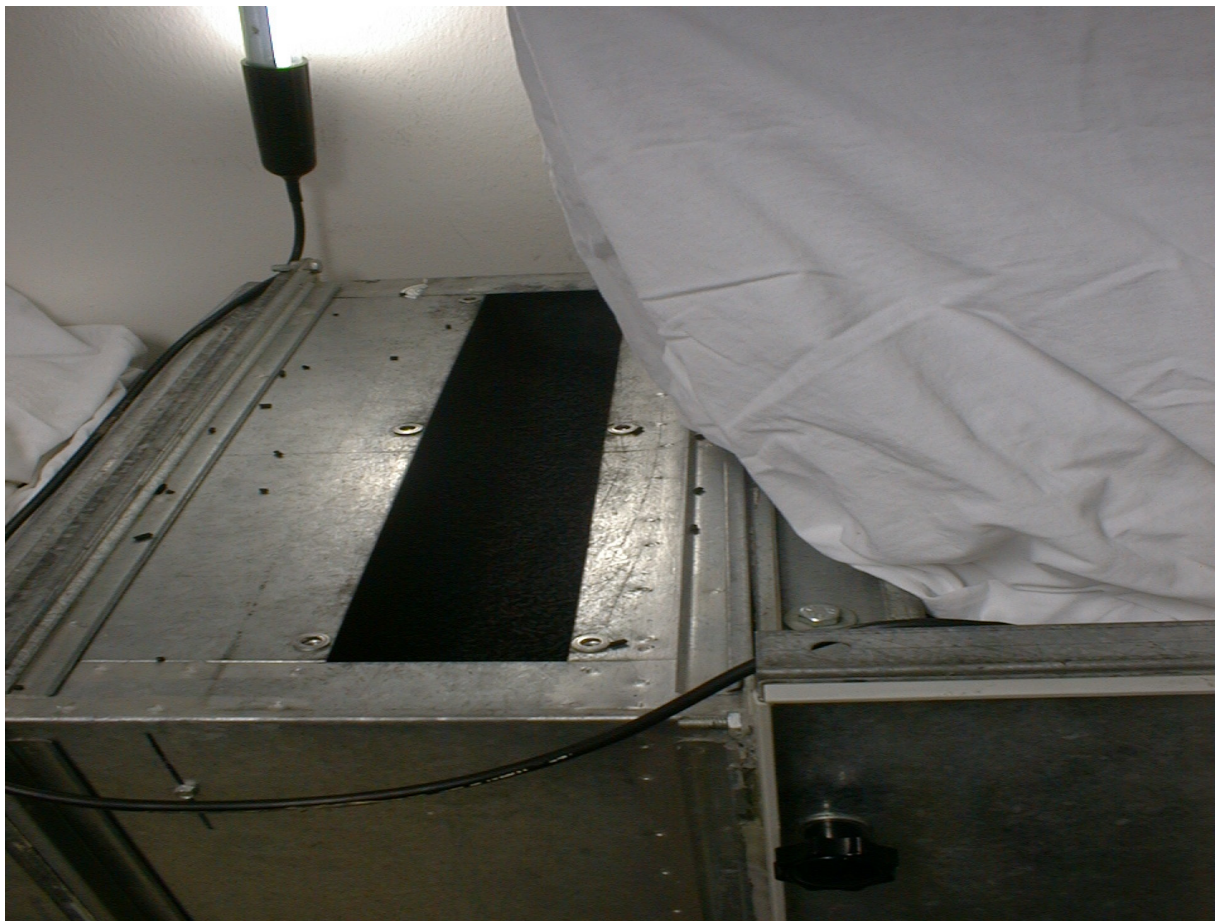
Bild 2: Schüttfilter, geöffnet
