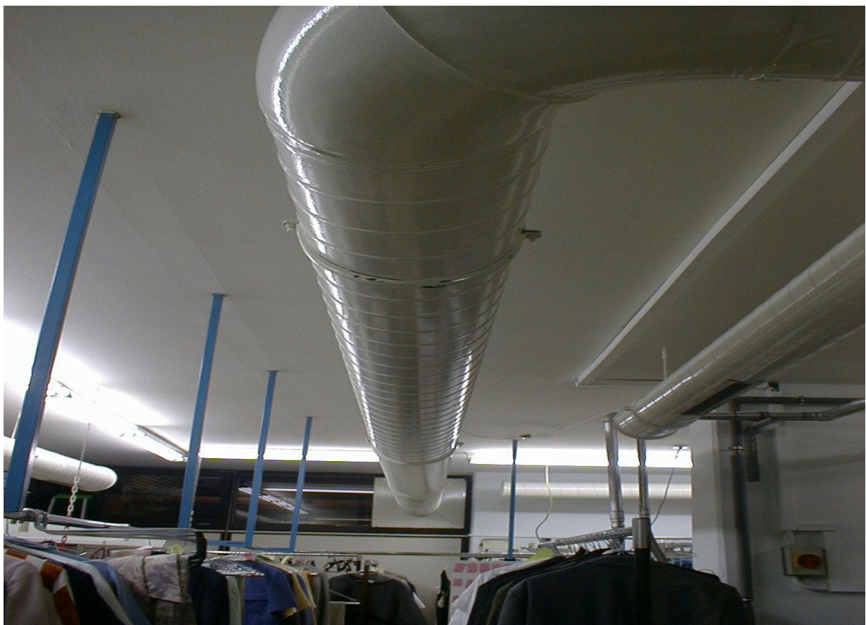
Bild 6: Mündung des Abluffrohres, Reingasseite
