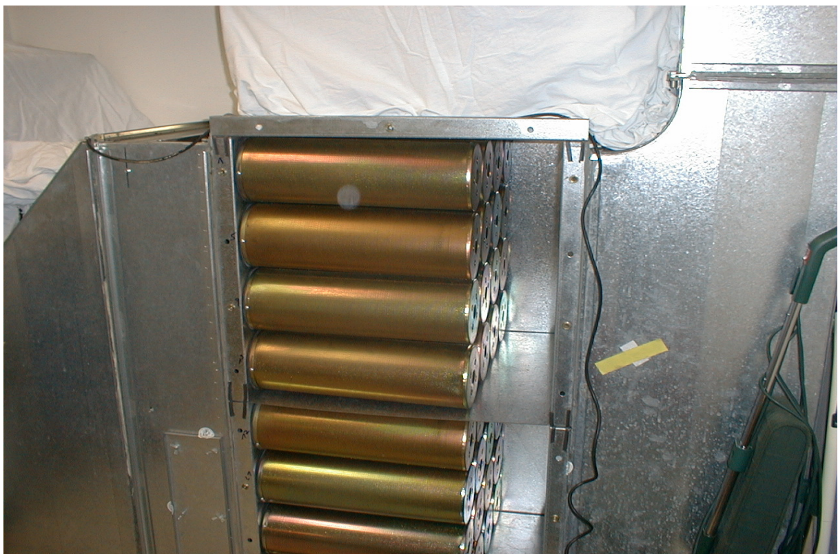
Bild 4: Ringfiltersystem mit Aktivkohlepatronen
