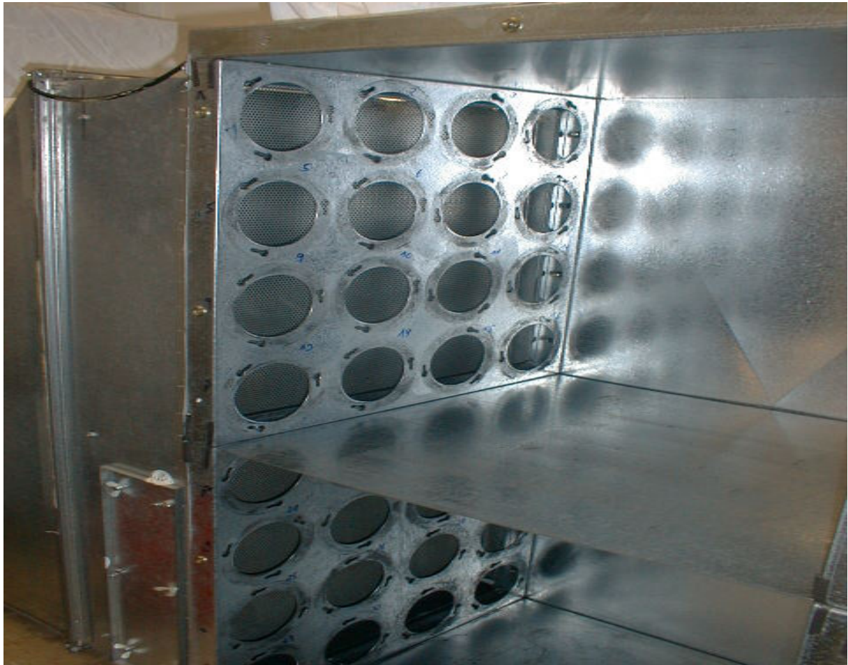
Bild 3: Ringfiltersystem ohne Aktivkohlepatronen
