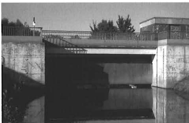
Abb. 15: HRB mit offenem Gerinne und Segmentwehr
