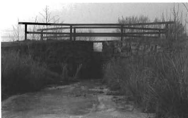
Abb. 13: HRB mit kleiner Dammhöhe, Schlitzlösung mit Dammbalkenverschluss. Es fehlt noch ein durchgehender Uferstreifen
