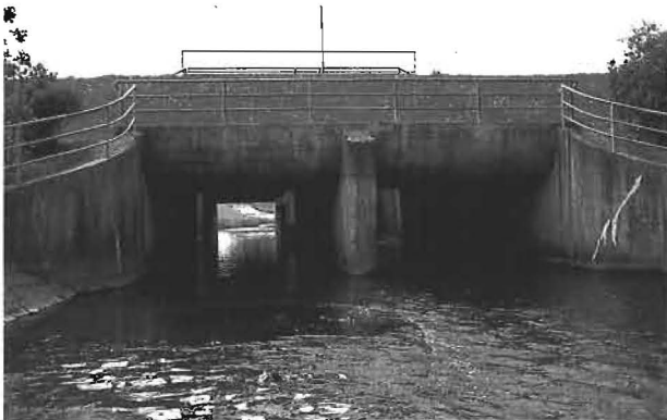
Abb. 10: Beispiel für ein Auslassbauwerk eines HRB mit zur Wanderung von Fischen ausreichender Belichtung
