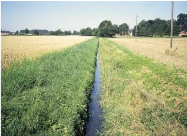
Abb. 83: Typisches Bild eines Tieflandbaches in der intensiven Kulturlandschaft: Der Bach ist begradigt und mit Steinschüttungen festgelegt, die intensiven Nutzflächen reichen direkt bis an das Ufer heran. Die einzeln stehenden Gehölze im Hintergrund können auch in Zukunft nicht annähernd die Funktion einer intakten Auenvegetation übernehmen.
