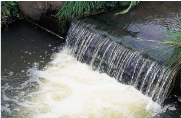
Abb. 85: Querbauwerke stellen in Fließgewässern oftmals unüberwindbare Wanderhinder-nisse v.a. für Fische dar. Viele dieser Barrieren können mit einfachen Mitteln rückgebaut oder beseitigt werden.
