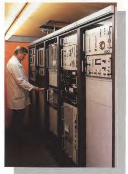
Schadstoffmeßplätze in der TEMES-Station
