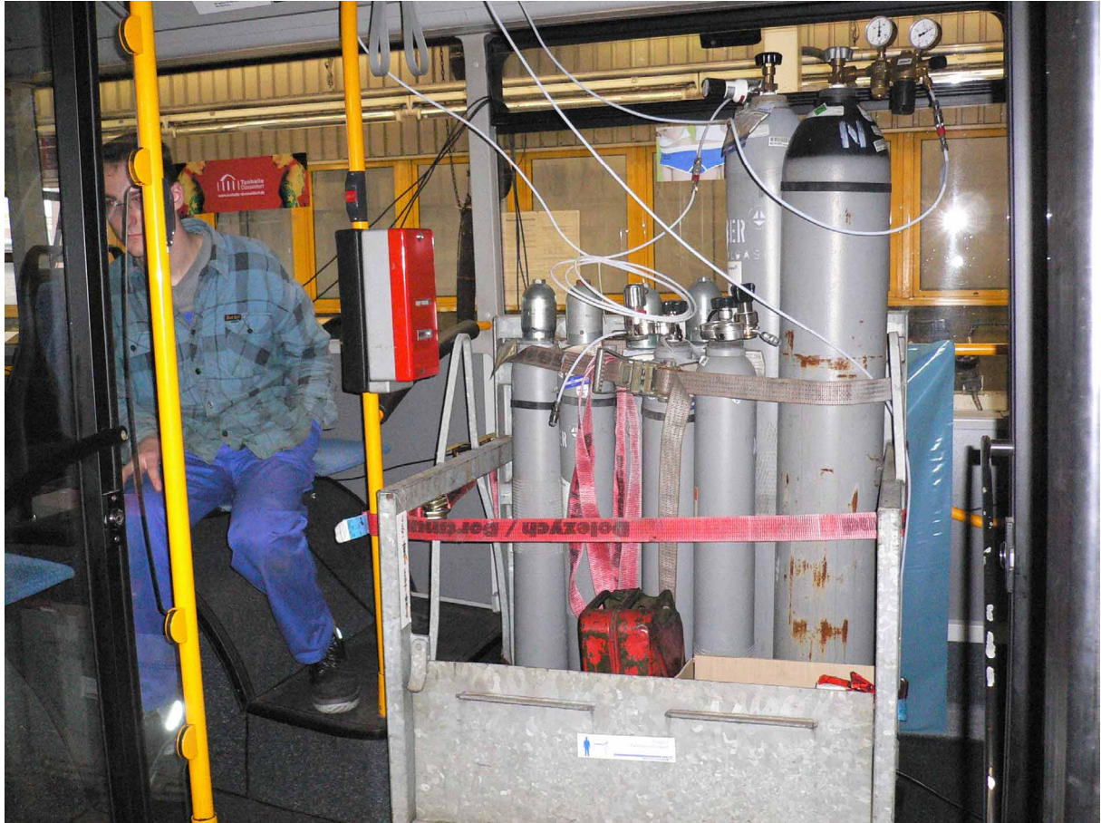
Abbildung 12: Raum für Messtechnik und Gasflaschenaufbewahrung
