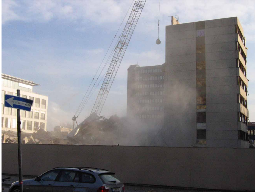
Abbildung 4: Staubentwicklung bei Abrissarbeiten eines Gebäudes in Düsseldorf
