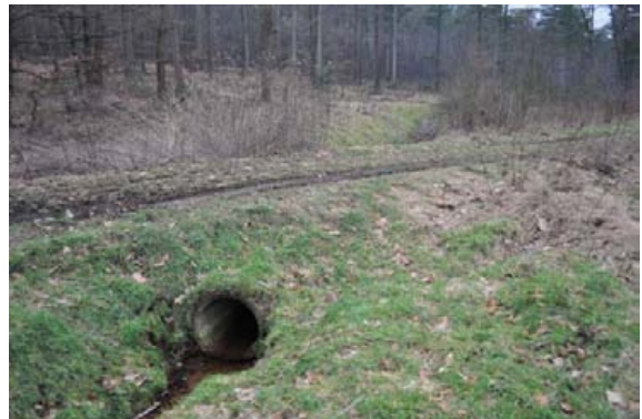
Verrohrung ohne Sediment
