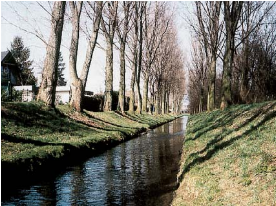
technisches Regelprofil (Trapezprofil)
