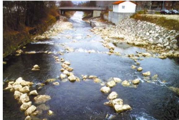
raue Rampe (Gumpenbauweise)
