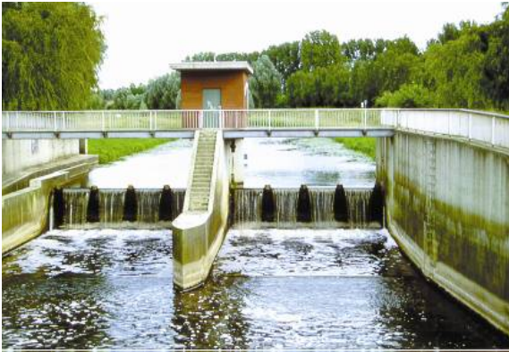
Absturz mit Fischwanderhilfe (links technischer Fischpass)
