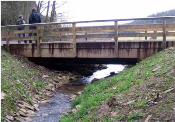
Brücke strukturell nicht schädlich
