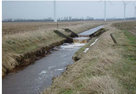
Absturz (Absturztreppe, >0,3 – 1 m)
