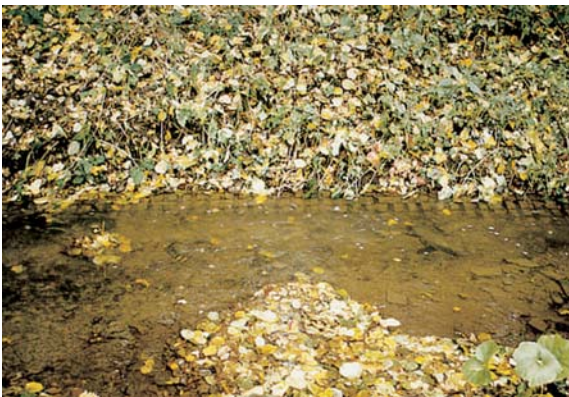
Massivsohle mit Sediment
