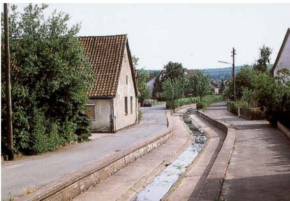
Massivsohle ohne Sediment
