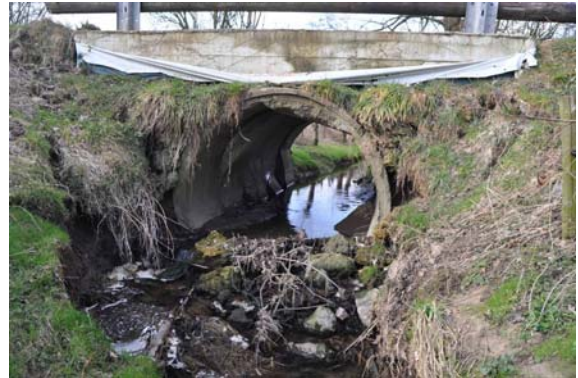
Verrohrung mit Sediment
