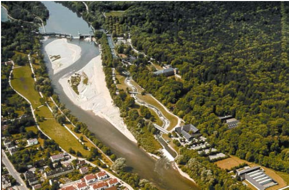
Absturz mit Umgehungsgerinne (rechts)
