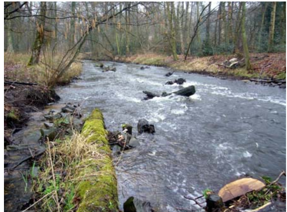
künstlich erhöht: raue Rampe mit Wurzelstubben
