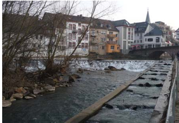
Absturz mit Fischwanderhilfe (Fischtreppe)
