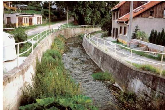
anthropogen kein Uferbewuchs (wegen Verbau)
