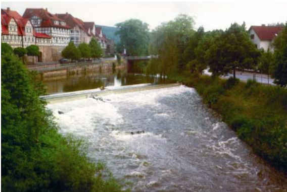
Absturz, unterhalb raue Rampe
