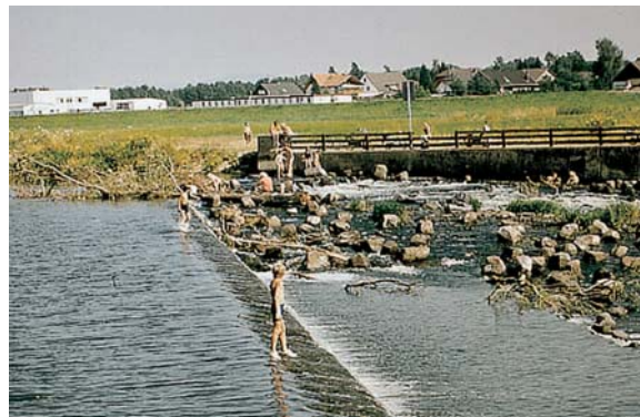
Absturz mit Teilrampe
