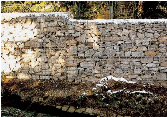
Steinsatz, unverfugt (Gabionen)
