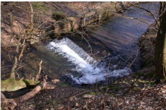
Absturz mit Teilrampe
