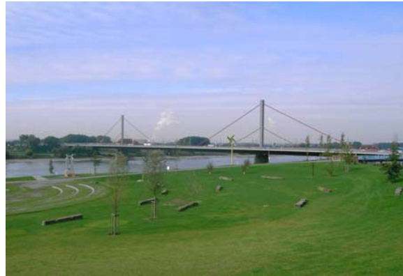
Brücke strukturell nicht schädlich
