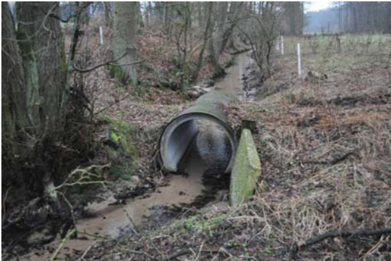
Verrohrung mit Sediment
