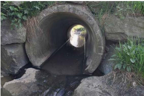
Verrohrung ohne Sediment
