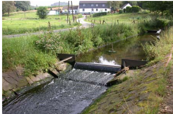
Absturz, unterhalb glatte Gleite an Pegel
