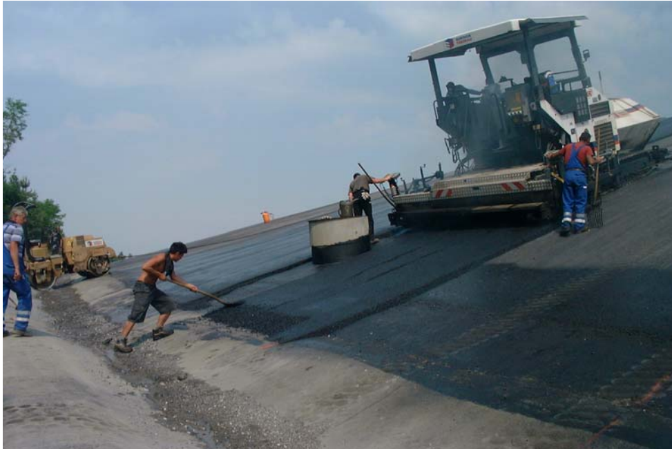
Abbildung 9 Einbau von Deponieasphalt mit einem Fertiger
