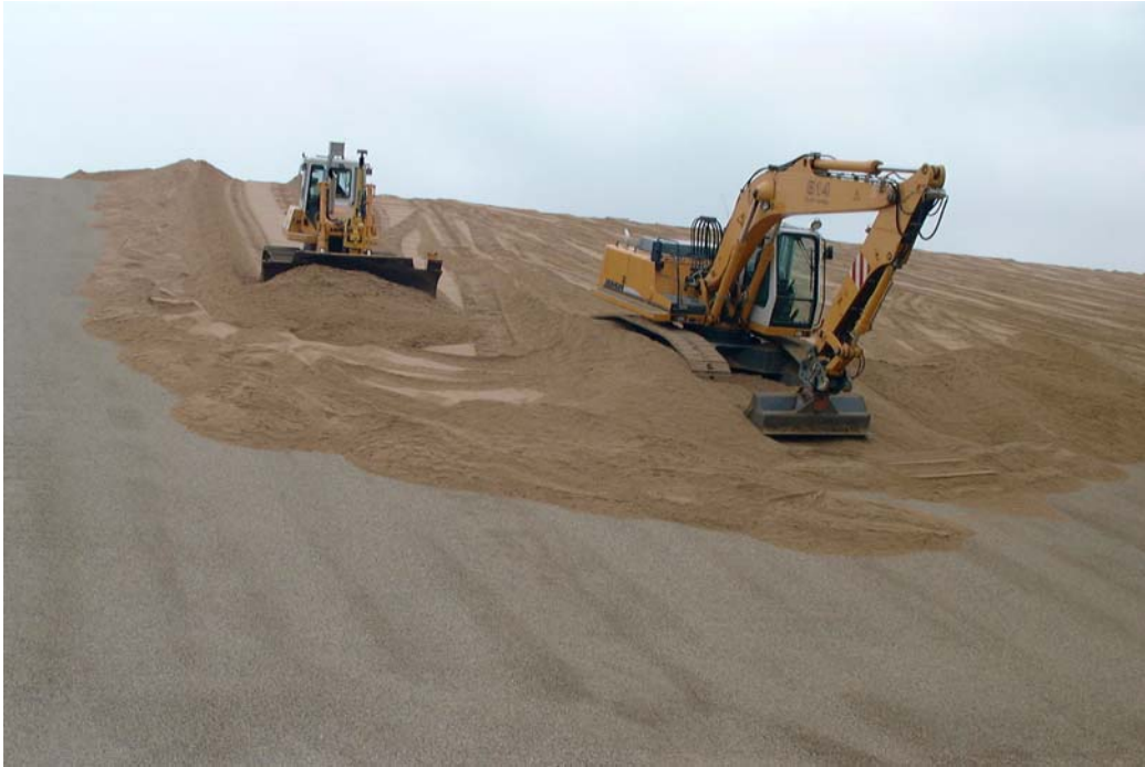
Abbildung 11 Einbau einer Kapillarsperre
