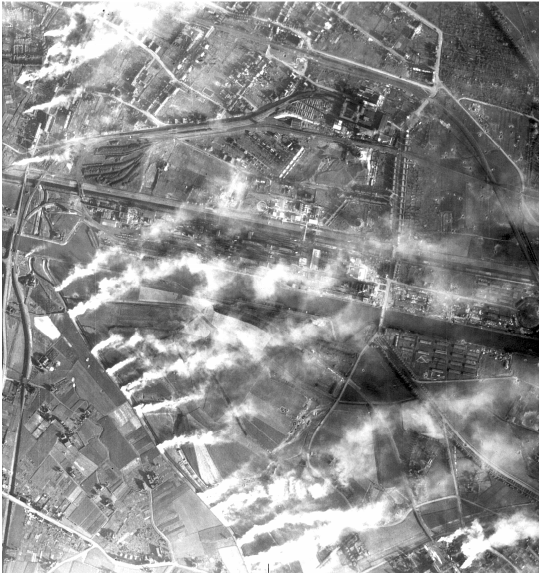
Abbildung 3: Nebelschutzanlage im Bereich der Zeche und Kokerei Nordstern. Der Ausschnitt aus einem Senkrechtbild der RAF-Aufklärung vom 28. Juni 1944 zeigt das Zechen- und Kokereigelände Nordstern, Gelsenkirchen. Der Anlagenschwerpunkt befindet sich auf der „Insel“ zwischen Emscher und Rhein-Herne-Kanal (Bildmitte). Sehr deutlich zeichnet sich die Konfiguration der Nebelschutzanlage ab. Zum Aufnahmezeitpunkt besteht noch keine geschlossene Nebeldecke; um so deutlicher treten die Einzelkomponenten der Anlage hervor. (Luftbild: Archiv des LfAO, Düsseldorf)
