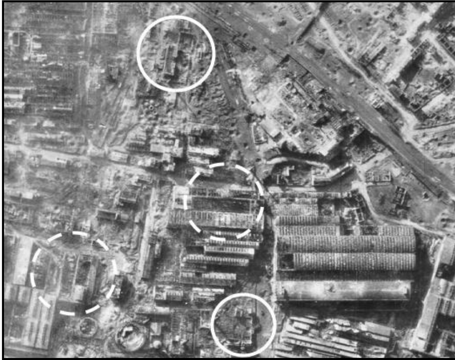
Abbildung 20: Luftbildausschnitt Industriegelände: Schadensdifferenzierung. Ausschnitt aus dem Senkrechtbild eines Industriegeländes, aufgenommen am 23. März 1944. Deutlich sind hier Totalschäden (durchgezogene Kreislinie) von unterschiedlich schweren Teilschäden (gerissene Kreislinie) zu unterscheiden. Luftbild: Archiv des LfAO, Düsseldorf
