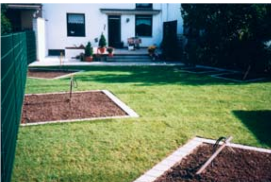
Abbildung 3.33 (oben links): Nach der Aufbereitung des Oberbodens und Herstellung des Feinplanums erfolgte die Verlegung von Fertigrasen
