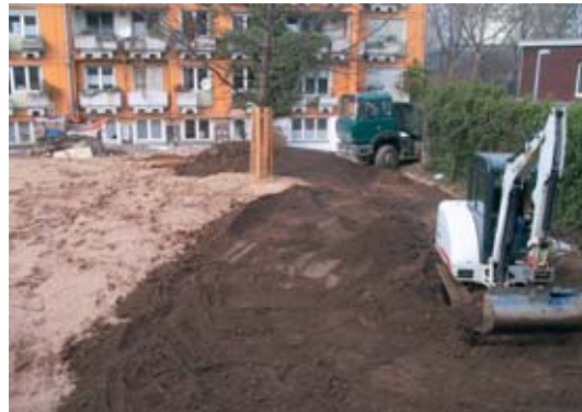
Abbildung 3.22: wurde bereits im Herbst 2003/Frühjahr 2004 saniert.
