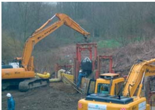
Abbildung 3.44: Herstellung des Drainagebauwerks; Befüllung mit Aktivkohle, März 2004
