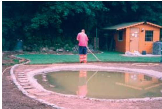
Abbildung 3.33 (oben links): Nach der Aufbereitung des Oberbodens und Herstellung des Feinplanums erfolgte die Verlegung von Fertigrasen
