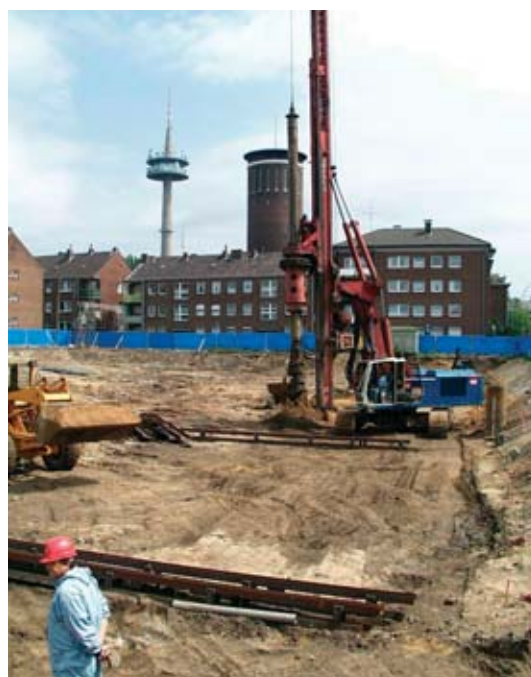
Abbildung 3.62: Großbohrung
