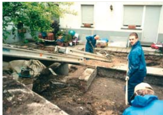
Abbildung 3.8: Detmolder Straße, Teilabschnitt 2 Handschachtung
