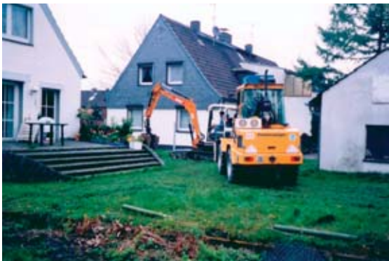
Abbildung 3.27: Vor Sanierungsbeginn nach Rodung der Bäume und Sträucher
