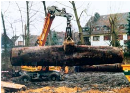
Abbildung 3.40: Bergung eines entleerten 10.000- Liter-Tanks
