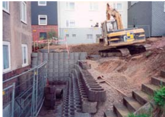
Abbildung 3.6: Detmolder Straße, Teilabschnitt 1 Böschung
