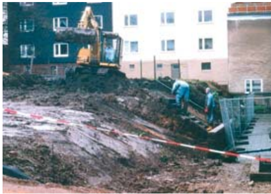
Abbildung 3.9: Detmolder Straße, Teilabschnitt 2 Handschachtung
