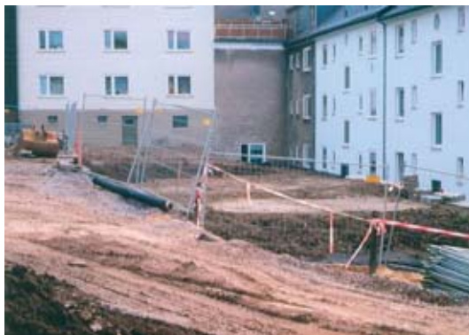
Abbildung 3.10: Detmolder Straße, Teilabschnitt 1 Einbau
