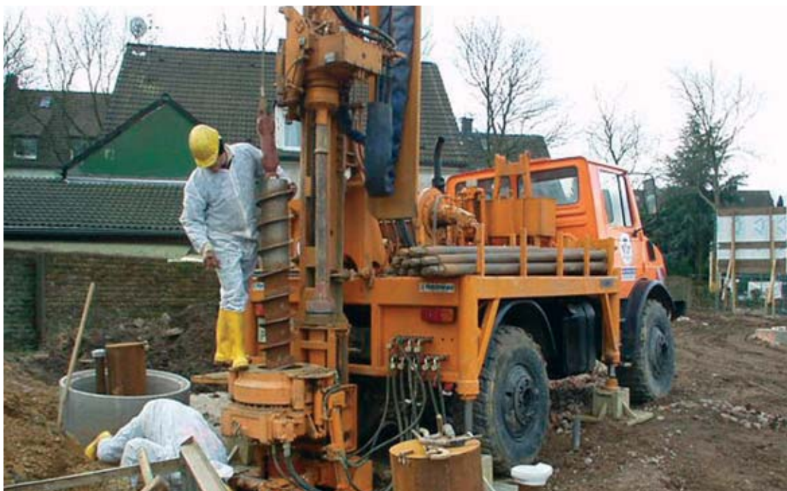
Abbildung 3.1 Bohrung eines Brunnen auf dem Gelände eines ehemaligen chemi- schen Kleinbetriebes in Essen-Schönebeck
