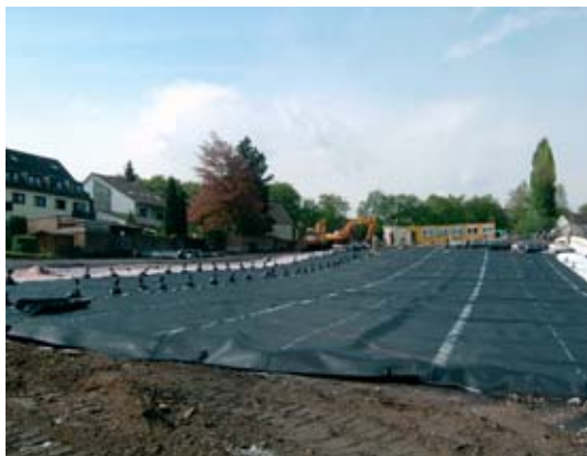
Abbildung 3.45: Verlegen und Verschweißen der Kunststoffdichtungsbahn, Mai 2004
