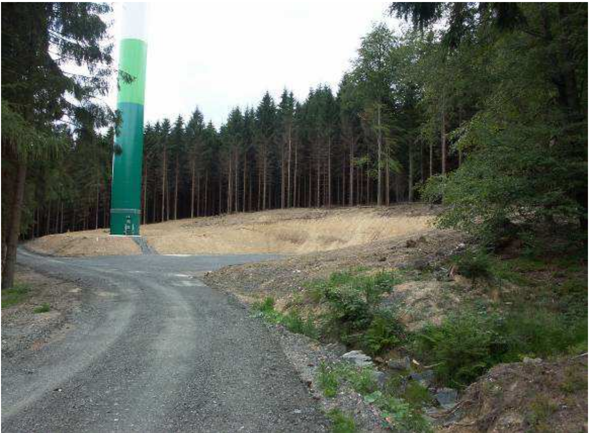
Abbildung 13: WEA-Standort, Zuwegung und ebene Kranstellfläche
